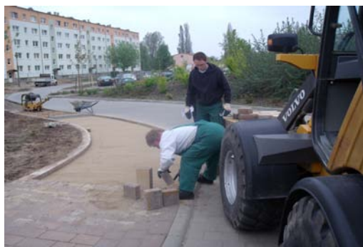
Ueckermünde Haffring 6-7 Betonpflaster
