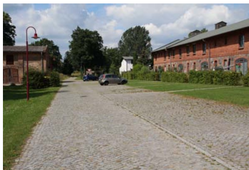
Remontepark Ferdinandshof -Natursteinpflaster
