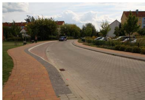
Bushaltestelle UEM - Betonverbundpflaster -
